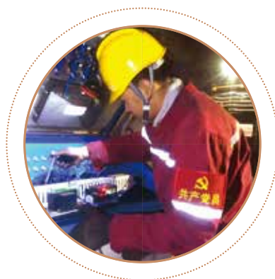
党员先锋岗排查隐患
